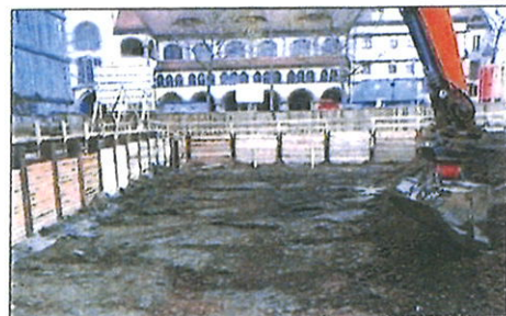
Abb. 4. Schichtenweiser Abtrag, verpflichtend bei baubegleitender KMR
