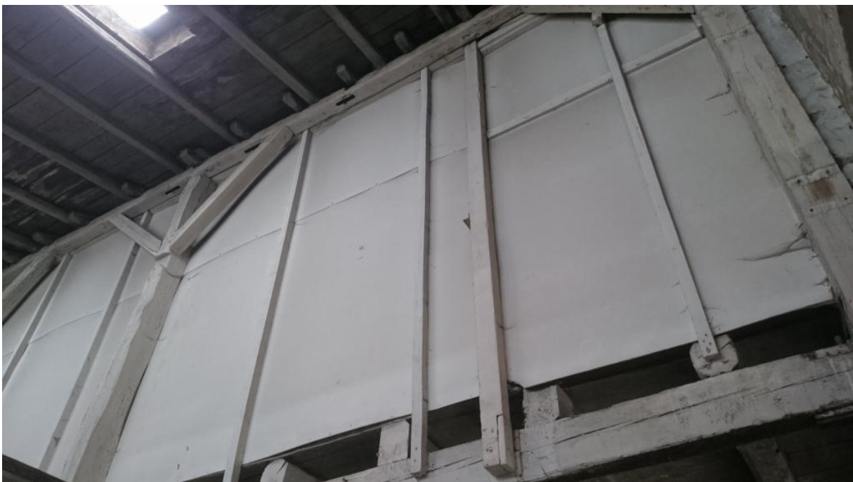
Abb. 19: Gebäude D, Innenraum; Balken an Wänden und unter dem Dach mit Spalten
