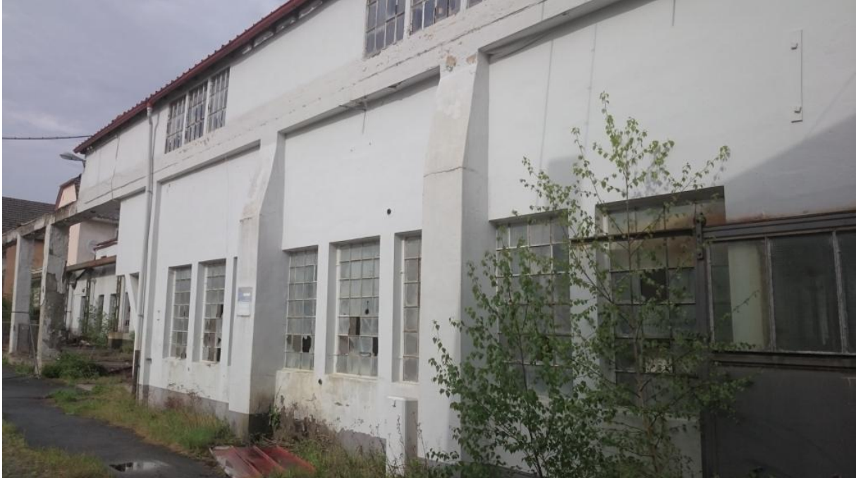
Abb. 16: Gebäude C, Außenansicht westl. Fassade
