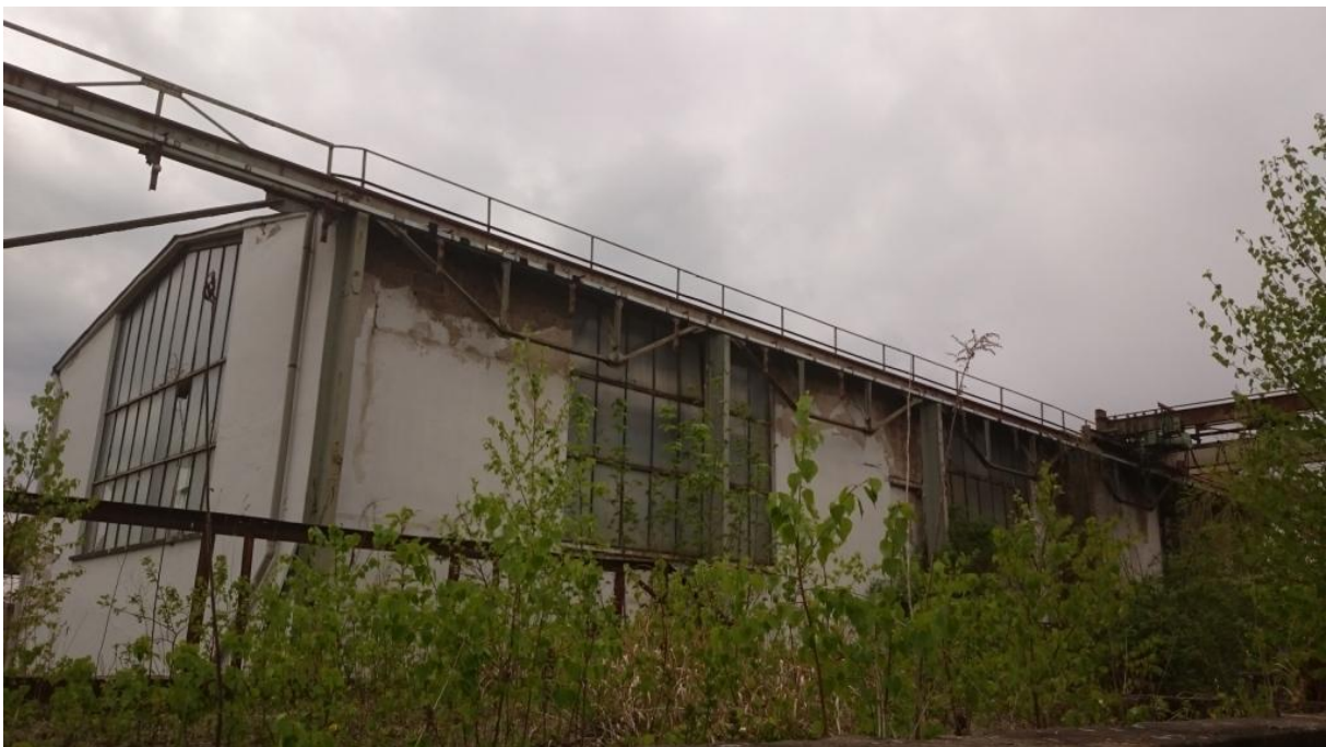
Abb. 9: Gebäude A, Außenansicht von Südosten
